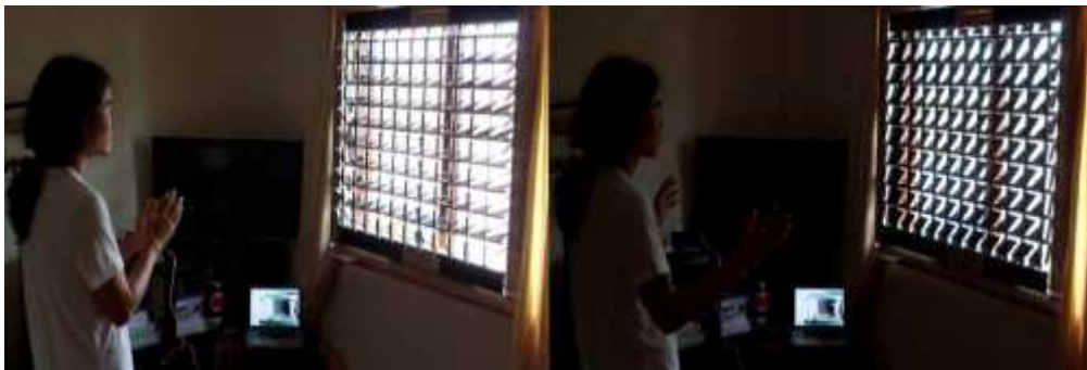
ภาพแสดงการปรับเปลี่ยนของแผงกันแดดโดยการควบคุมระบบด้วยมือ
